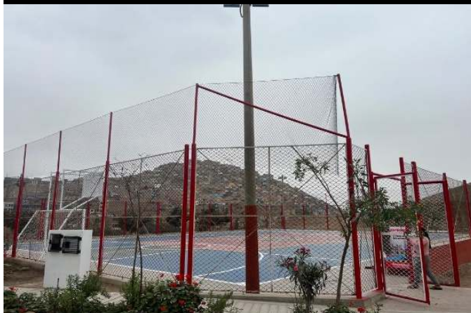
LOSA DEPORTIVA EN EL A.H. NUEVO ISRAEL
