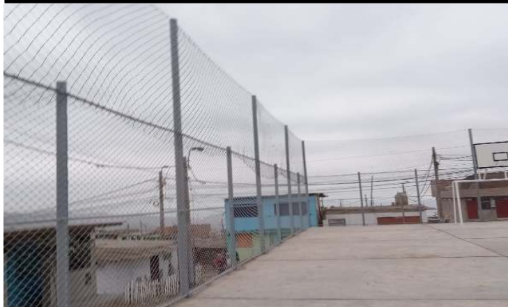
LOSA DEPORTIVA DEL A.H. AMPLIACIÓN TIWINZA
