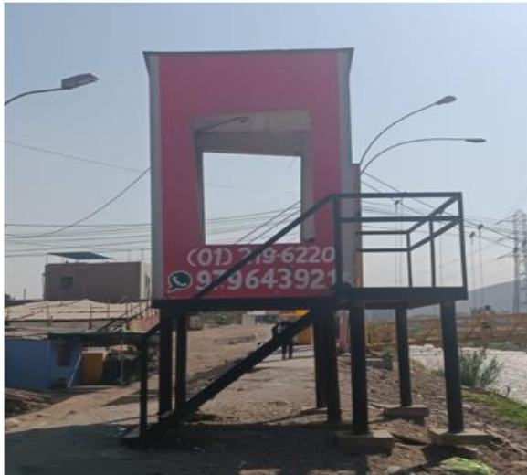
CASETA PUENTE EL SOL
